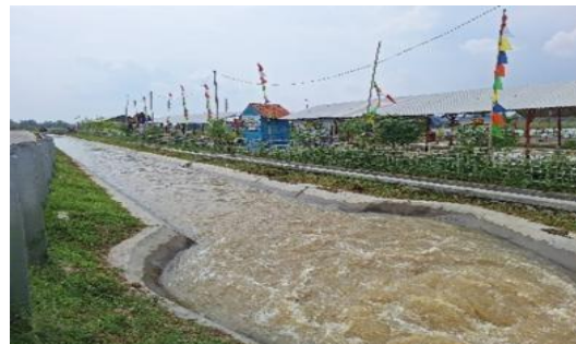
Gambar 1. Irigasi Primer di Kecamatan Kasemen
